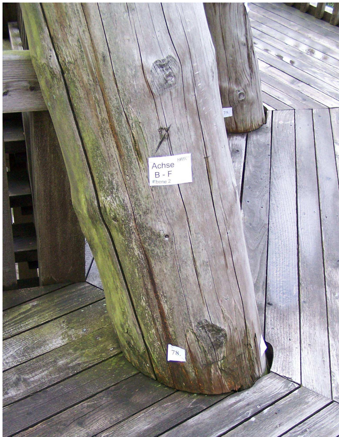
Abbildung 9: fehlender Abstand am Durchdringungspunkt der Pfosten durch die Ebenen
